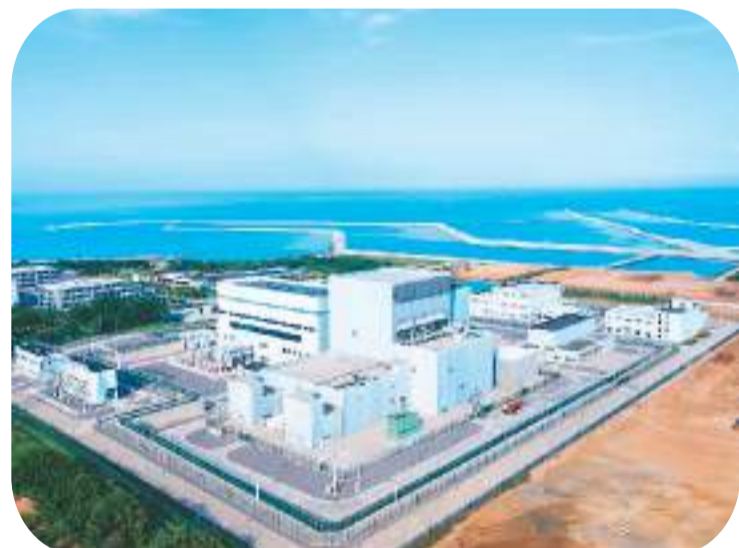
12月6日，国家重大科技专项标志性成果、全球首座第四代核电站——华能石岛湾高温气冷堆核电站示范工程在山东荣成投入商业运行。 孙文湛摄
