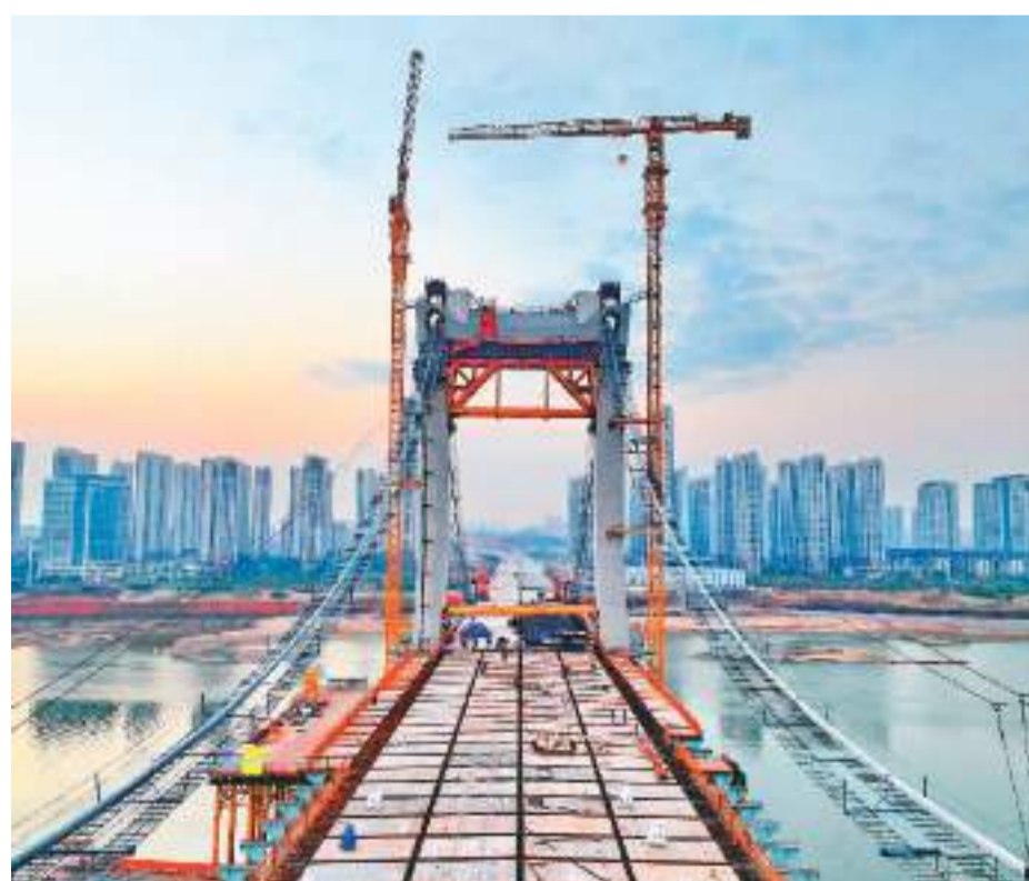
近日，由江西南昌市政公用集团建设、中铁大桥局承建的洪州大桥过江主塔结构贯通。该桥采用“昌”字形双塔，为全国最大跨度比钢混组合梁自锚式悬索桥。图为洪州大桥施工现场。朱海鹏摄（人民视觉）
