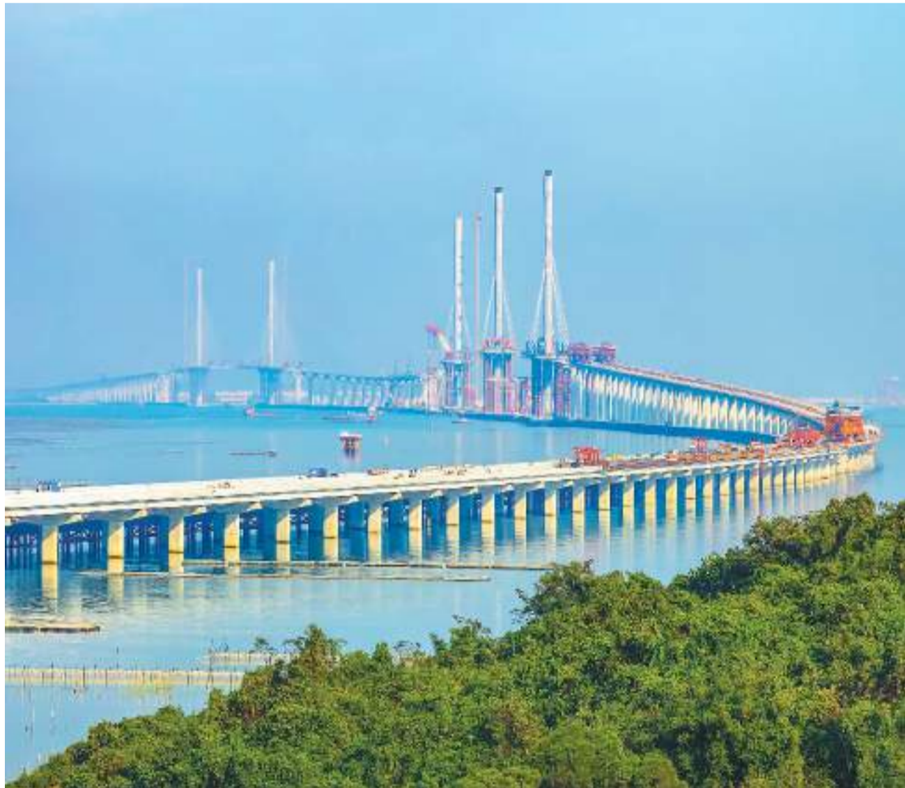
近日，黄茅海跨海通道中引桥顺利合龙，该项目两座海上主桥——黄茅海大桥与高栏港大桥成功完成海上“牵手”。黄茅海跨海通道连接广东省珠海市和江门市，建成通车后将成继港珠澳大桥、深中通道后，粤港澳大湾区第三条重要跨海通道。图为黄茅海跨海通道建设现场。
