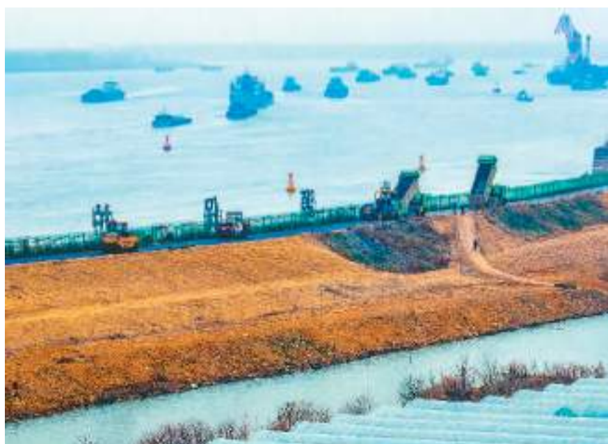
▲近日，安徽省芜湖市政府、水利部门加强对重大水利工程建设日常调度，把握关键节点，抢抓工程进度，确保如期完成建设任务。图为芜湖市繁昌区新港镇圩圩江堤边，施工人员在长江芜湖河段整治工程工地上开展防汛道路沥青摊铺作业。
