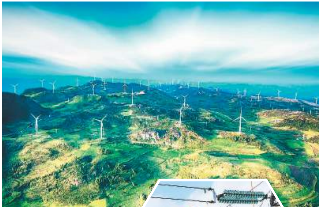
▲ 中国大唐集团有限公司云南文山锦屏山风电项目172台风电机组近日全部并网发电。该项目平均海拔2210米，装机容量86万千瓦，预计每年可输送20亿千瓦时清洁电能。至此，总装机容量110.3万千瓦的云南首个高原山地百万千瓦级风电基地建成投产，为当地电力供应提供保障。图为云南文山锦屏山风电项目一瞥。
