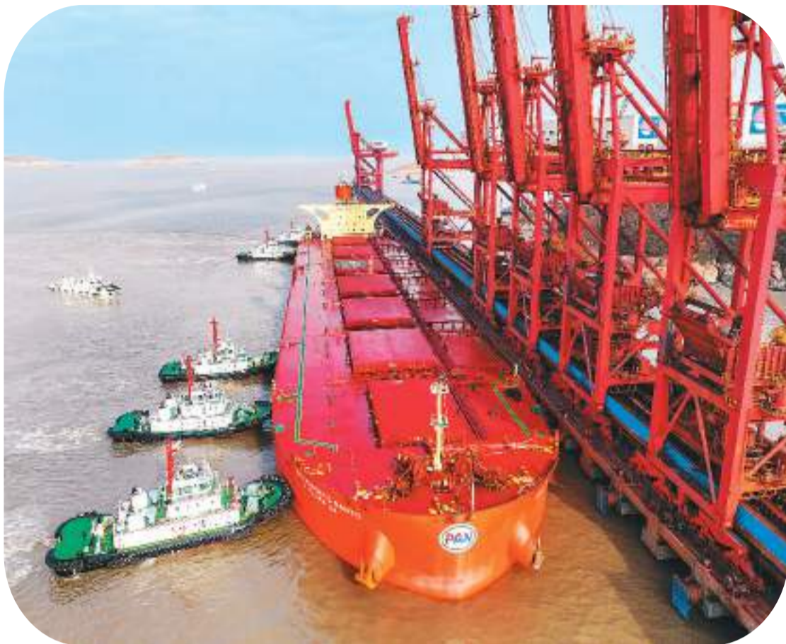
▲1月9日，装载39.3万吨铁矿石的“艾斯普利托”轮顺利靠泊浙江舟山衢山港区鼠浪湖卸船码头。 姚峰摄（人民图片）
