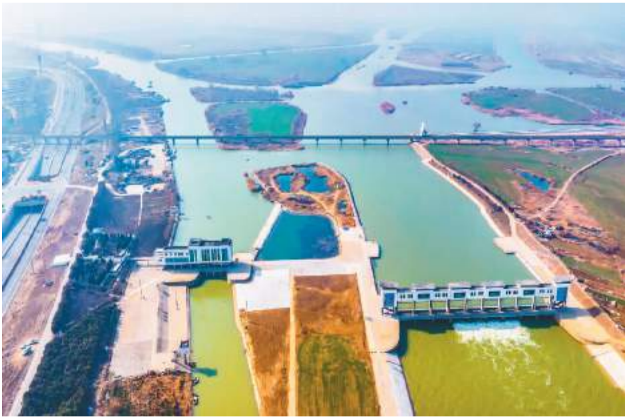
江苏省宿迁市沭阳县近年来加大水环境治理力度，将护水、治水作为乡村振兴的重要抓手，在严格实施三级河长制的同时，推进水利基础设施现代化建设，满足农业灌溉需求，助力粮食稳产、增产。图为1月11日，沭阳县新沂河沭阳枢纽南偏泓闸在开闸放水，保障下游小麦冬灌。张连华摄（人民视觉）
