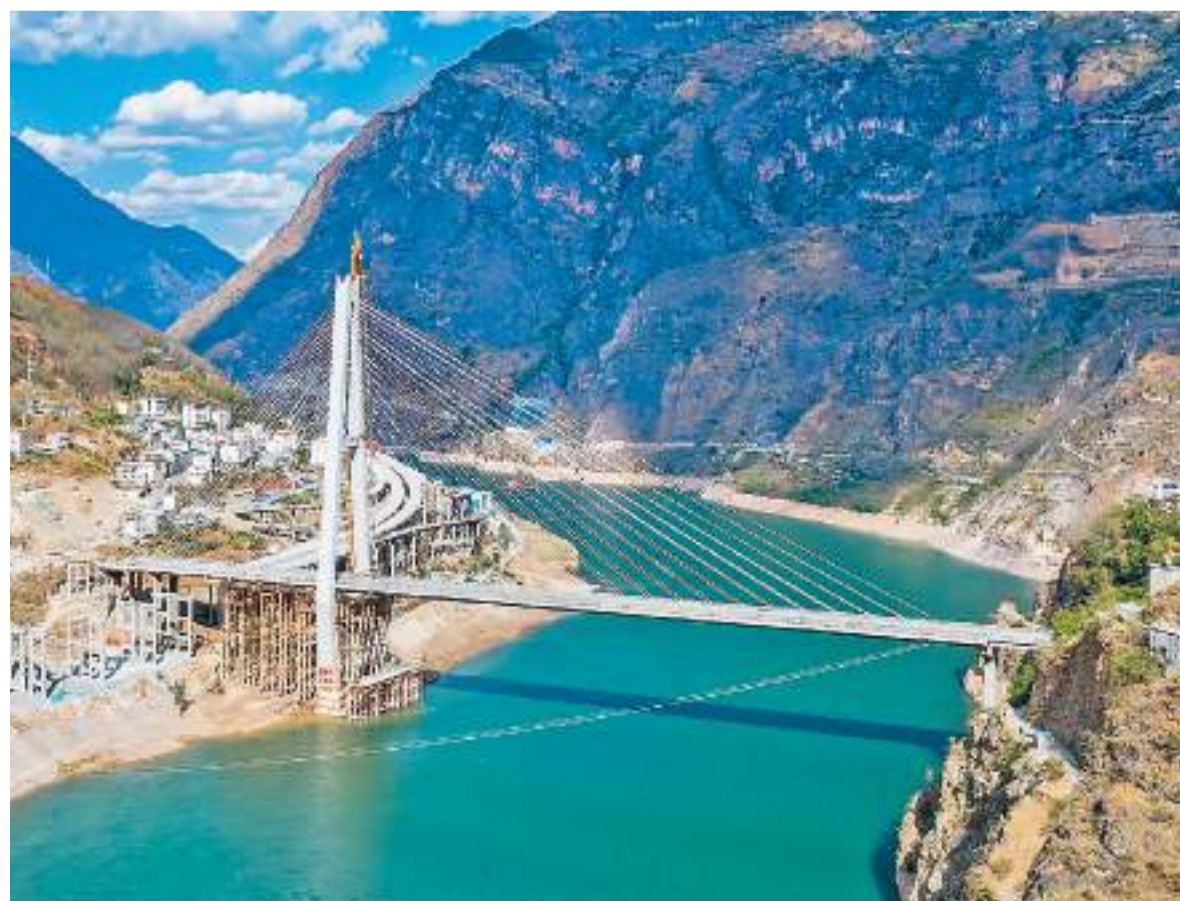
日前,贵州都市至云南香格里拉市高速公路(以下简称“都香高速”)云南昭通段全线建成通车,西南地区新增一条连接川滇三省的高速公路。都香高速云南昭通段全长97公里,通车后,从云南昭通市昭阳区到四川金阳县的通行时间从6小时缩短至约1小时。
