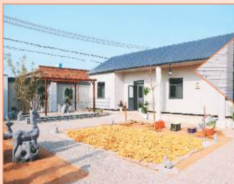
位于河北省故城县的3D打印民居。
