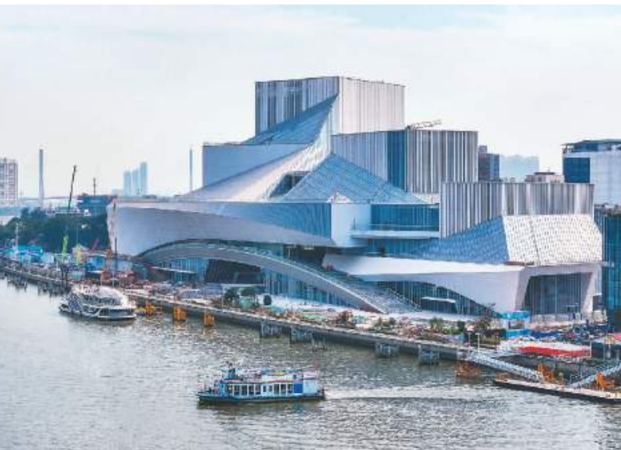
由中建三局承建的白鹤潭大湾区艺术中心项目即将竣工。该项目位于广州珠江白鹤潭，集广东美术馆、广东非物质文化遗产展示中心、广东文学馆“三馆合一”，目前已进入室内装修工程收尾阶段。图为白鹤潭大湾区艺术中心外景。 新华社记者 刘大伟摄
