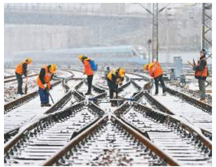
2月20日，河南迎来新一轮寒潮雨雪天气，中国铁路郑州局集团有限公司启动一级应急响应，及时组织开展站场扫雪除冰作业和行车设备巡视检查工作，最大限度降低恶劣天气对铁路运输秩序的影响。图为工作人员在郑州站进行雪中检查和扫雪除冰作业。王 玮摄（人民视觉）
