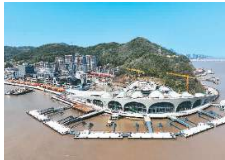
春节假期过后，各地企业纷纷开工生产，呈现一派繁忙景象。图为2月19日，浙江省舟山市普陀区东港(半升洞)客运站及城市广场建设工程有序推进中。
