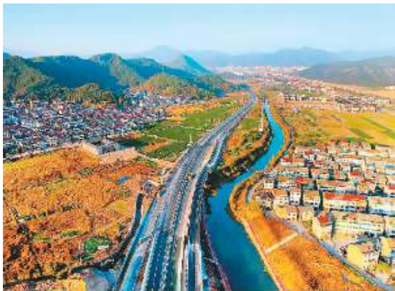
近日,由中建八局承建的浙江省重点工程余温公路(浙江余姚—温岭公路)临海江溪至沿江段(除东导渠段外)建成通车。图为临海市铁路大道下穿通道入口段。 钟成堡摄(人民视觉)
