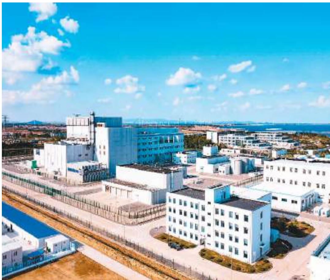
中国重大科技专项标志性成果、全球首座第四代核电站——华能石岛湾高温气冷堆核电站示范工程在山东荣成投入商业运行。 孙文湛摄
