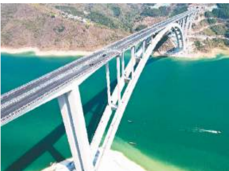
2月15日，天峨县发生4.4级地震，处于震中的天峨龙滩特大桥安然无恙。
