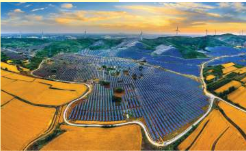
宿州市埇桥区符离集光伏发电电场
