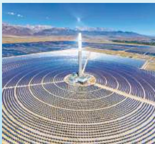
農行青海分行支持塔拉灘光伏產業園區建設。
