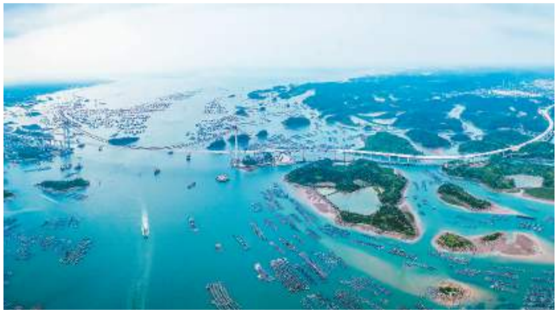
广西壮族自治区钦州市龙门大桥是广西首座千米级跨海悬索桥,项目路线全长7.637公里,其中桥梁总长6597米。大桥建成通车后,防城港与钦州港的行车时间将由原来的1.5小时缩短至25分钟左右。图为4月17日,正在建设中的龙门大桥。何文摄(人民视觉)
