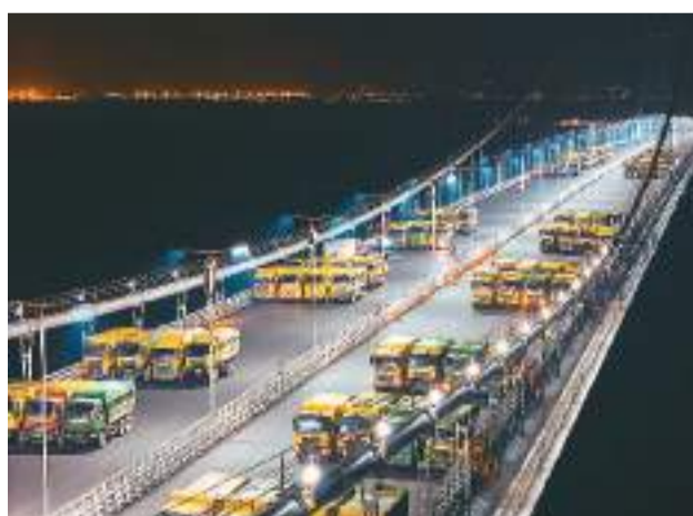
图为伶仃洋大桥进行荷载试验。
