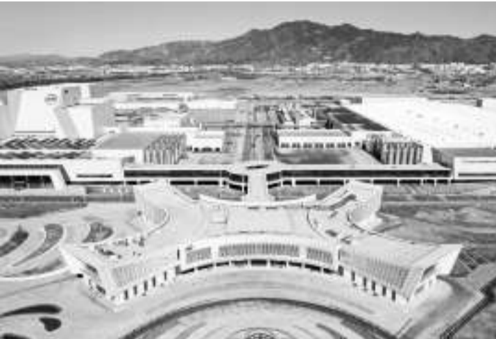
呼和浩特市土默特左旗伊利现代智慧健康谷全球智能制造产业园(4月2日摄,无人机照片)。
