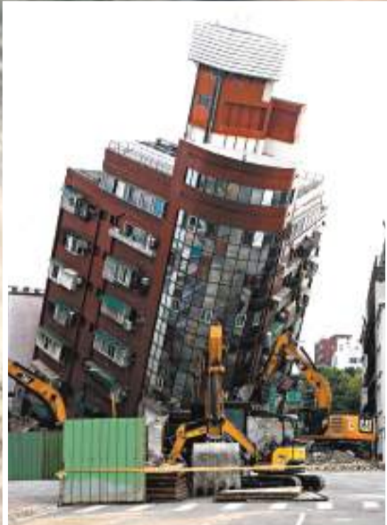
◆4月4日，花蓮市區居民的生活秩序已基本恢復。圖為因震傾斜嚴重的天王星大樓。中新社
