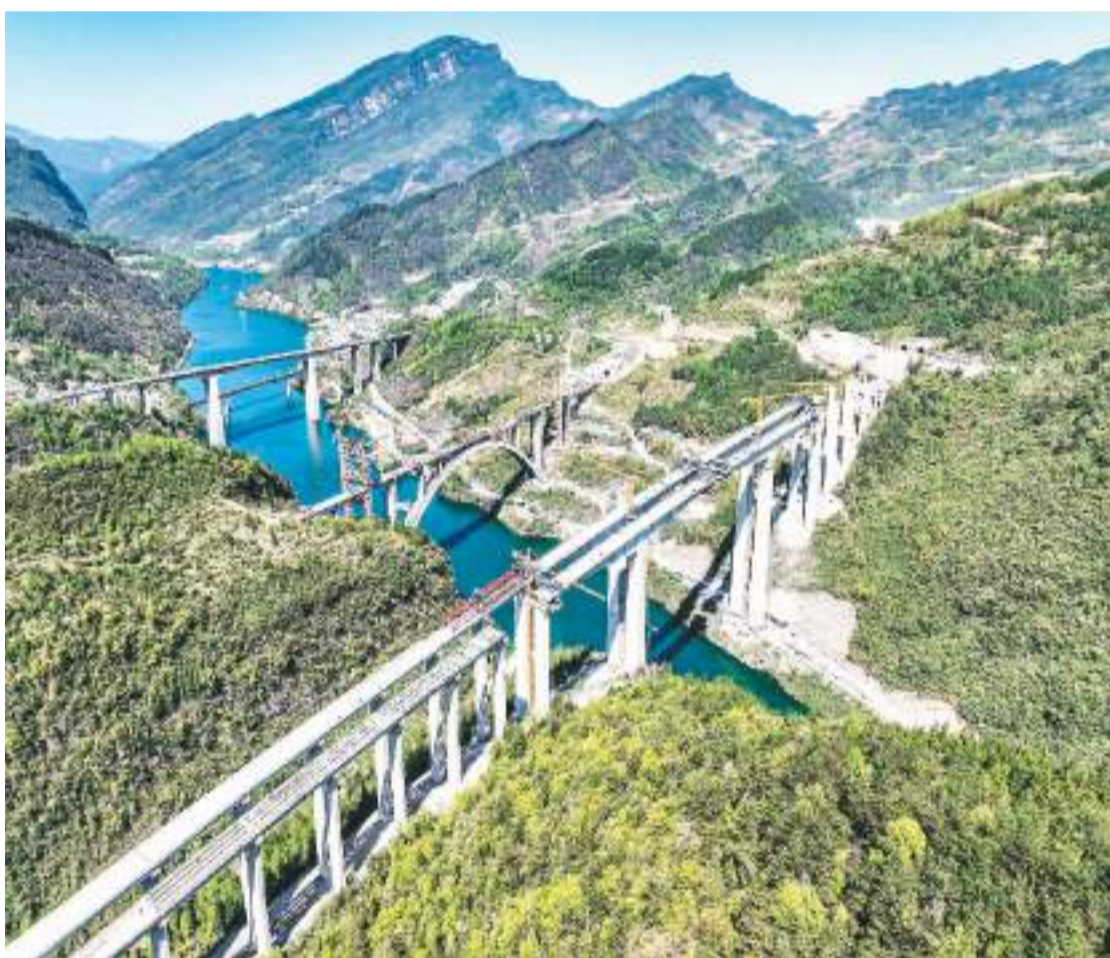
黄草江特大桥（右）位于重庆市武隆区境内，全长1702米，主跨220米，横跨乌江及G319国道，目前建设已进入最后的冲刺阶段，项目建成后将有放缓渝湘复线高速通行压力。
