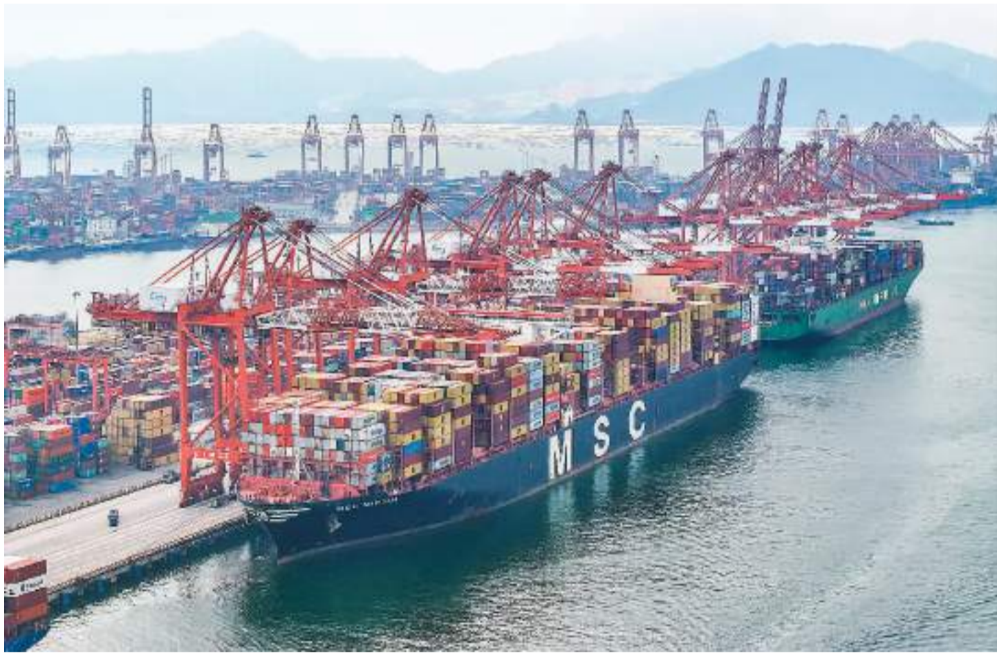
近年来，广东省深圳市不断发展枢纽经济，巩固国际航运枢纽港地位。图为停泊着超大型集装箱船舶的深圳赤湾集装箱码头，桥吊作业一派繁忙。陈志强摄（人民视觉）
